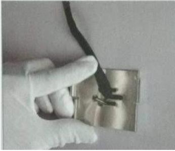
4. После выпрямления кабеля пропускается винтовая пластина через подвеску.
