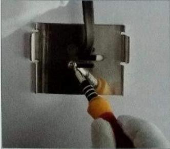
5. Затяните винты, зафиксируйте подвесную пластину.
